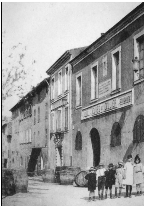
La Coopérative de Camps autrefois. On aperçoit, au premier étage entre 2 fenêtres, le cadran solaire
